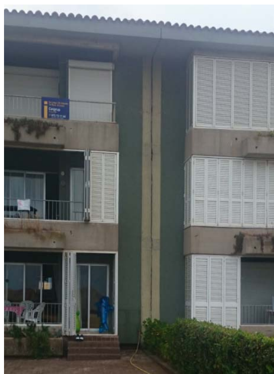
Figura 37 – Apertura de las juntas de dilatación entre bloques del edificio Voramar causada por el basculamiento de la escollera que sustenta el paseo marítimo. Categoría de daños 1 a 2 (Muy leves a Leves) según Burland 1995 .
