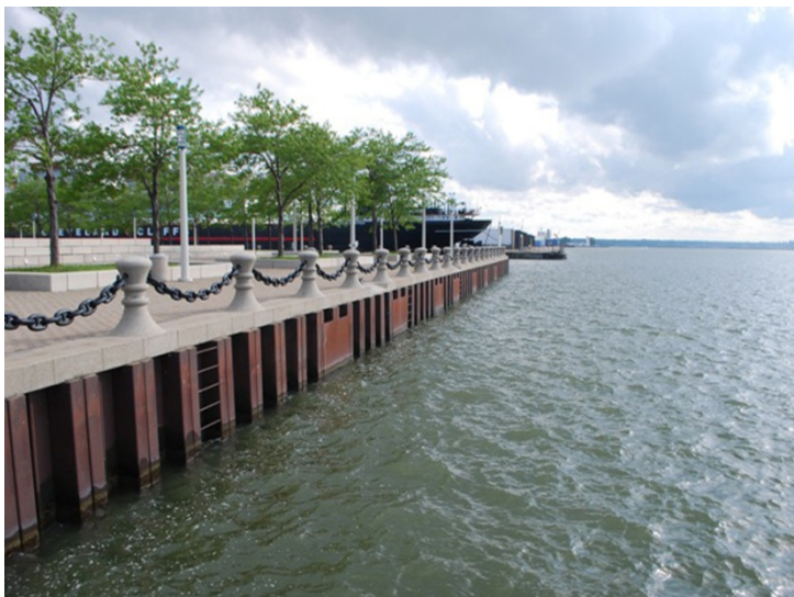
Figura 44 – Aspecto de un muro mamparo con tablestacas metálicas y acondicionado como paseo marítimo en la costa norte de Ohio (Cleveland, EEUU).
