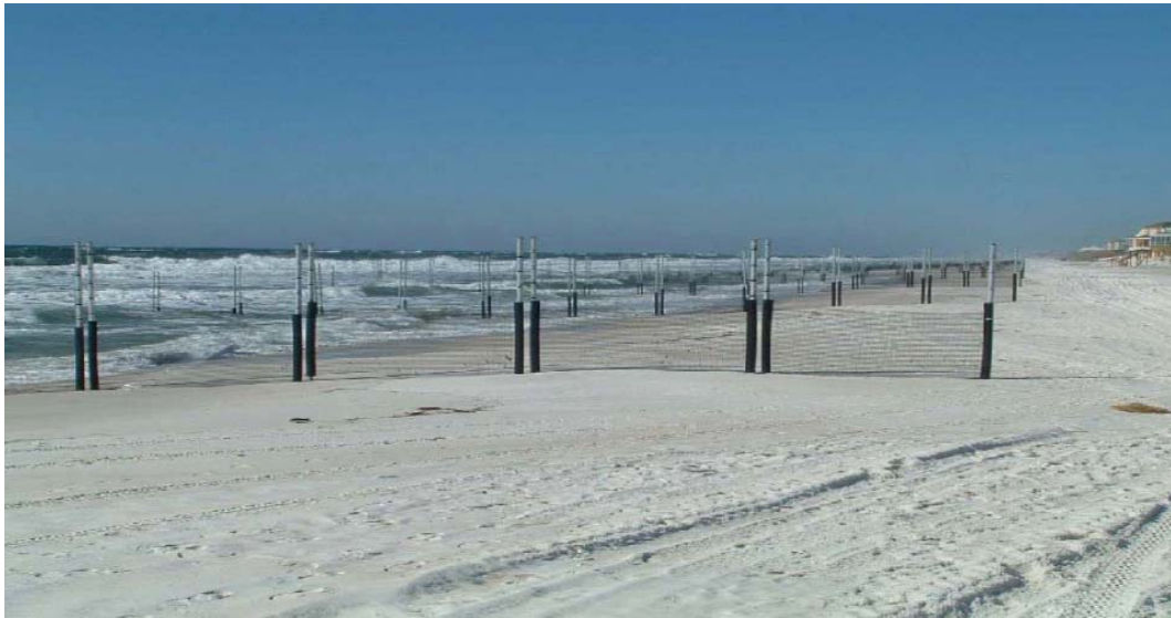
Figura 58 – Sistema de barreras permeables temporales para retención de arena fuera de la temporada turística (Inlet Beach, Florida, EEUU).
