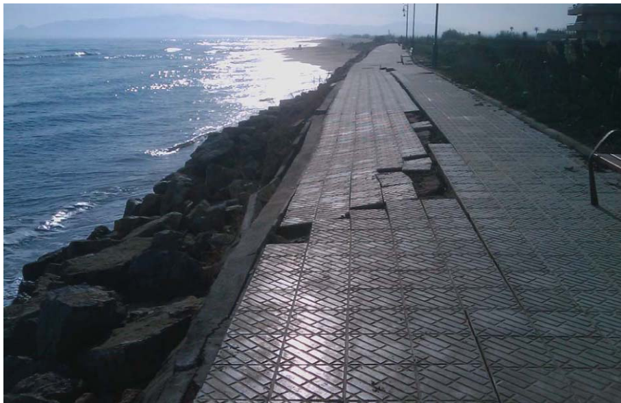
Figura 25 – Aspecto del paseo a principios de diciembre de 2010, con la escollera ya desestabilizada por socavación del oleaje al desaparecer la playa.
