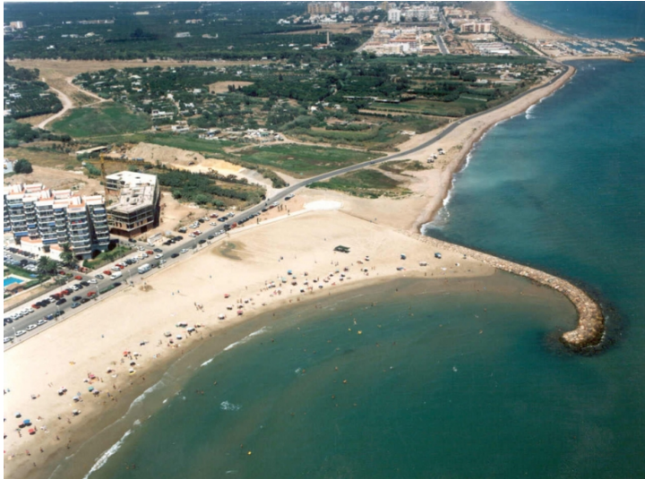
Figura 48 – Aspecto de un espigón perpendicular a la costa, en la playa de Canet. Nótese el cambio de orientación del morro del espigón para disminuir la erosión en el trasdós del espigón.
