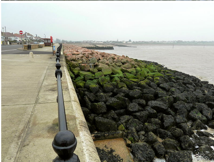
Figura 45 – Aspecto de una protección superficial mediante bloques de escollera en la costa norte de Kent (Reino Unido).
