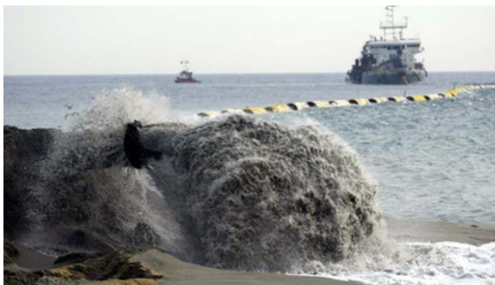
Figura 54 – Reposición de arena en las playas del Maresme mediante el dragado del fondo marino con barco draga.
