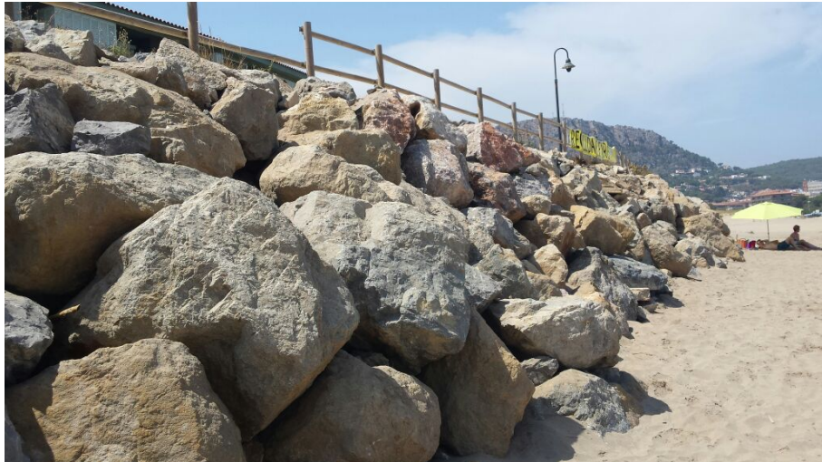
Figura 33 – Bloques de la escollera de sostenimiento del paseo marítimo totalmente basculados y desencajados por efecto de la incidencia directa de la olas y suponiendo un riesgo para los usuarios de la playa. Obsérvese que es la escollera reconstruida en el año 2013 que se muestra las figuras 28 y 29.
