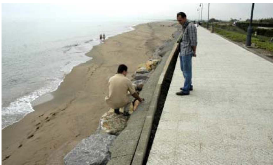
Figura 24 – Aspecto del paseo a finales de septiembre de 2010 donde se abrieron cicatrices indicadoras de inestabilidades siendo inspeccionadas por técnicos de costas. Se observa la reducción de la anchura de la playa respecto a las imágenes de años anteriores (Web Ayuntamiento Torroella de Montgrí).
