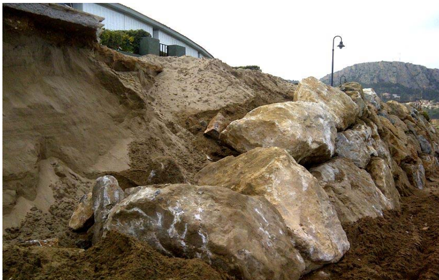
Figura 28 – Obras de restitución de la escollera de protección mediante piedras de gran tonelaje, Abril 2013. Obsérvese la falta de cimentación de la escollera, y el uso de hechadizos para completar el trasdós del muro.
