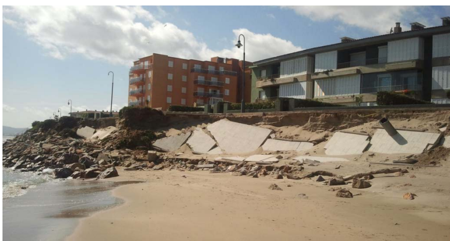
Figura 27 – Vista hacia el sur de los daños en el paseo de Els Griells una vez pasado el temporal de levante del mes de Marzo de 2013. No hay protección de playa, la escollera de protección se ha hundido parcialmente y el paseo marítimo ha colapsado quedando expuestos en la dinámica litoral parte de los bienes urbanos de la zona.
