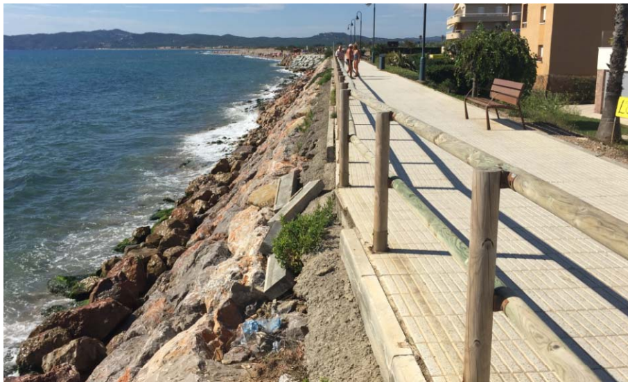
Figura 34 – Rotura de los paramentos del paseo y primeras grietas en el pavimento. Nótese el desplazamiento entre el techo de la escollera y el hormigón de limpieza que se situó en coronación. Escollera construida el 2011.
