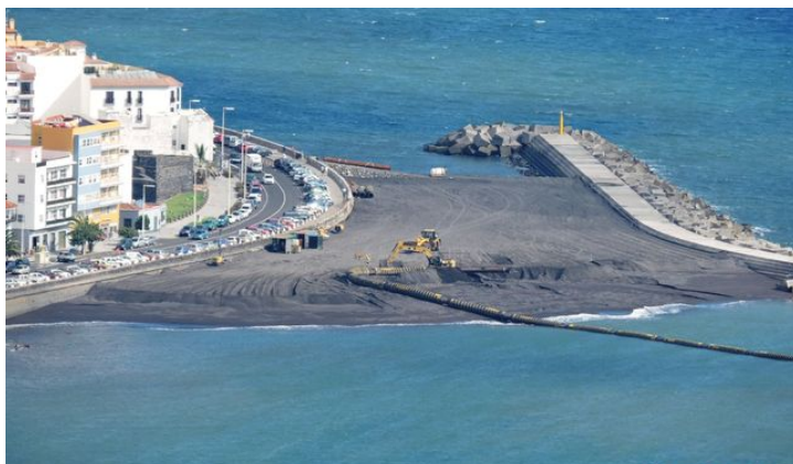
Figura 55 – Construcción de una playa artificial en Santa Cruz de la Palma mediante el dragado de arena del fondo marino con barco draga.
