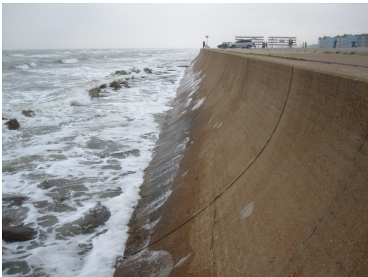
Figura 43 – Aspecto de un muro rompeolas en Galveston (EEUU) con una protección de escollera a su pie.
