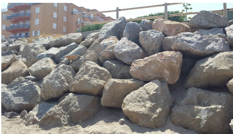
Figura 5 – Bloques de la escollera de sostenimiento del paseo marítimo totalmente basculados y desencajados por efecto de la incidencia directa de las olas.
