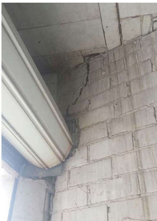
Figura 36 – Grietas en tabiques en el edificio Artit causadas por el basculamiento de la escollera que sustenta el paseo marítimo. Categoría de daños 1 a 2 (Muy leves a Leves) según Burland 1995 .
