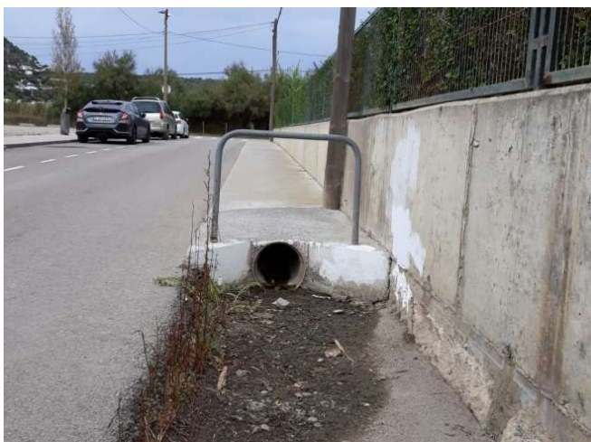
Imatge 16: Tub de desguàs del carrer Camèlia.
